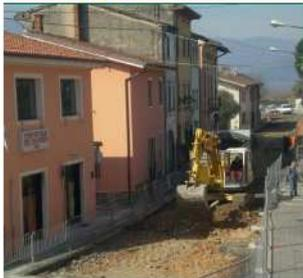
Sono iniziati i lavori per l'abbassamento del manto stradale e l'urbanizzazione in via della Chiesa. Un lavoro complesso e molto impegnativo che ovviamente comprende anche un nuovo posizionamento dei servizi (acquedotto, gas) che si trovano nel sottofondo stradale con i relativi allacci alle utenze. L'intervento della pubblica amministrazione comprende anche il rifacimento dei marciapiedi e della pubblica illuminazione. La tipologia dei marciapiedi è analoga agli interventi
